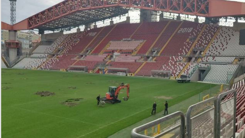
Prato stadio. Tocco di Trieste: nuovi lavori al via
